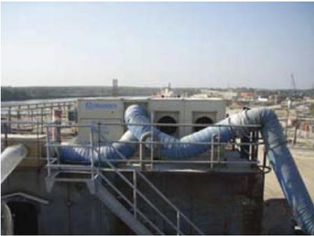
Fig. 4: Refrigerant dehumidifier
